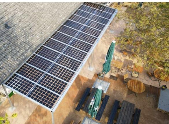
Die PV-Carports und PV-Terrassen von GridParity sind Selbstbausätze, die mit Doppelglas-Modulen ausgestattet sind. Diese Module sind nach EN12600 für die Überkopfmontage zertifiziert und in verschiedenen Transparenzgraden erhältlich (bis zu 40%). Sie werten jedes Gebäude, jede Einfahrt und jeden Garten auf, indem sie nicht nur ästhetisch ansprechend sind, sondern auch funktionalen Nutzen durch die Erzeugung von Solarenergie bieten.
