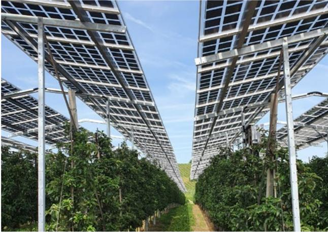
In der ersten Bauphase des AgriPV Projektes in Kressbronn wurden über 1100 Almaden M50 Doppelglasmodule mit 40% Transparenz installiert. In weiteren Bauabschnitten sollen leistungsstärkere Module oder Module mit höherer Transparenz eingesetzt werden. Auch eine noch dichtere Modulordnung mit 2 Modulen auf jeder Seite soll untersucht werden. In diesem Fall soll das Regenwasser aufgefangen und für die direkte Pflanzenbewässerung genutzt werden.
