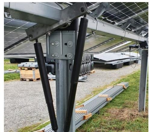
Robuster und langlebiger Antrieb auf solidem Fundament nach statischer Berechnung
