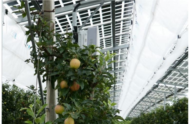
Die Agri-PV-Pilotanlage oberhalb der Apfelplantage des Obsthofs Bernhard besteht aus einem Metallgerüst, auf dem Solarmodule montiert sind. Es handelt sich um besonders stabile Almaden-Doppelglasmodule mit einer Transparenz von ca. 40%. Durch die spezielle Montage erhalten die Bäume trotz der Teilverschattung ausreichend Licht. Der erzeugte Ökostrom wird in das Netz des Energieversorgers Regionalwerk Bodensee eingespeist. Kressbronn ist die südlichste Gemeinde Ba-
