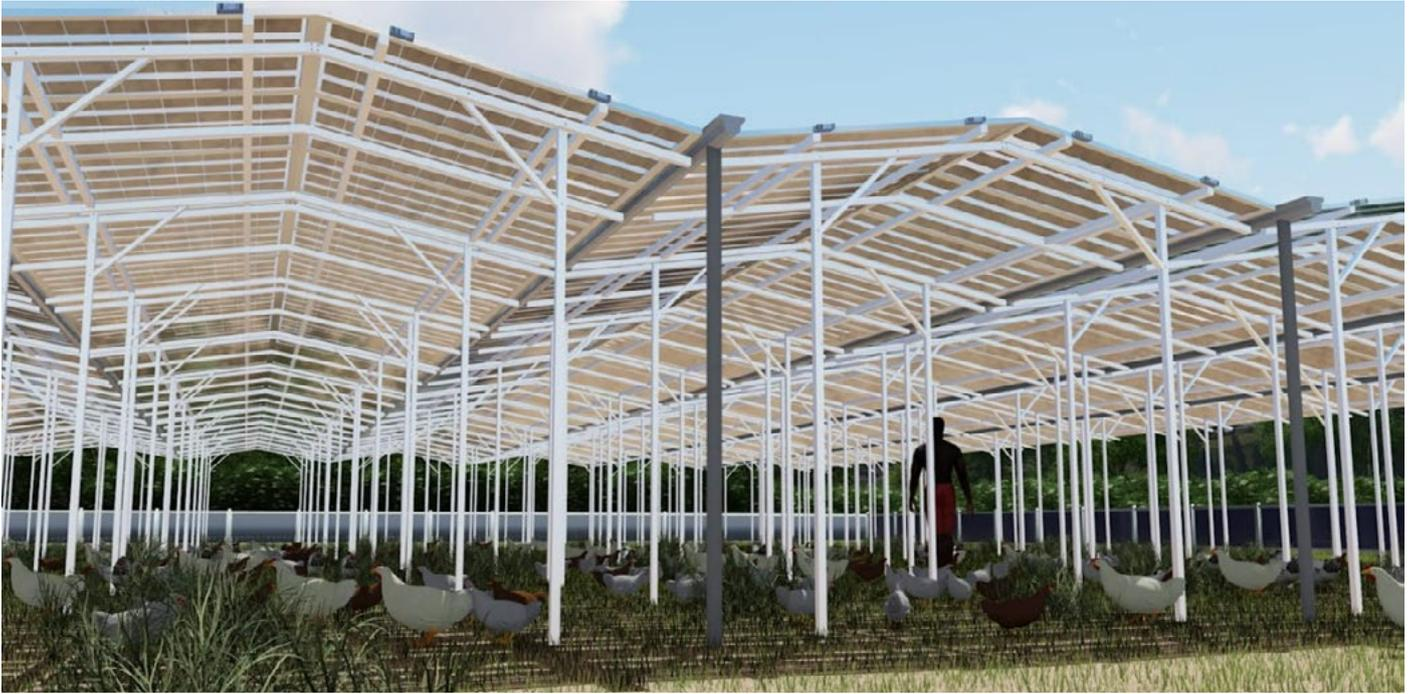
1,1 ha **Hühnerfreigehege** mit Stall und Wasserführung: 5 m Reihenabstand, 1.100 kWp/ha, Investition ohne Netzanschluss ca. € 1.265.000, Stromertrag p.a. bis zu 1.160 MWh = € 232.000 € bei 0,20 € kWh. Regenwassergewinnung in Brandenburg (590 mm Niederschlag) 5.300 m<sup>3</sup> Wasserüberschuß p.a., ausreichend für 2,5 ha Bewässerung.
