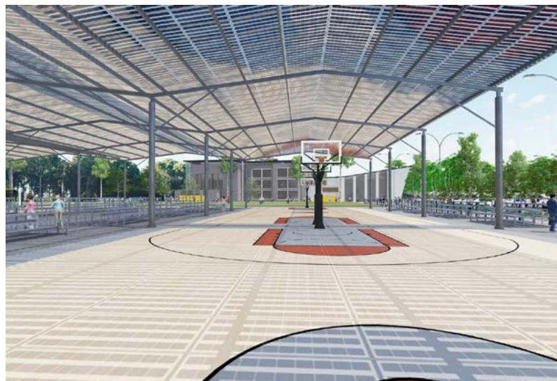
Durch den Einsatz von semitransparenten Doppelglas-Solarmodulen können Sporteinrichtungen ihre Energieeffizienz verbessern und gleichzeitig eine moderne und attraktive Umgebung schaffen. Diese Technologie bietet eine perfekte Kombination aus Funktionalität und Ästhetik und trägt wesentlich zur nachhaltigen Entwicklung bei.
