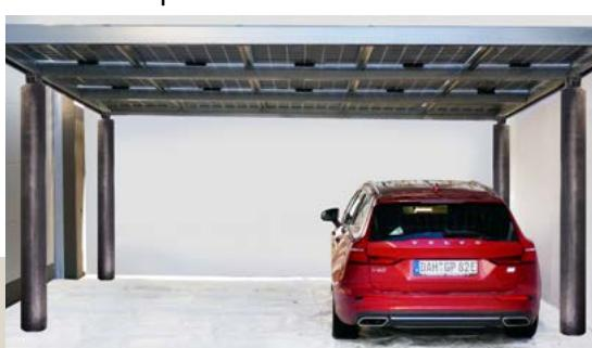
Verzinkte gekantete Stahlprofile auf Säulen aus Spezialstahl
