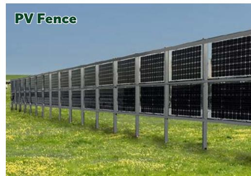
AgriPV kombiniert die Produktion von Nahrungsmitteln (landwirtschaftliche und gärtnerische Nutzung) mit der Stromerzeugung durch Photovoltaik auf der gleichen Fläche.
