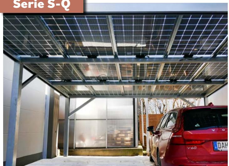
Verzinkte gekantete Stahlprofile auf gekanteten Stahlstützen
