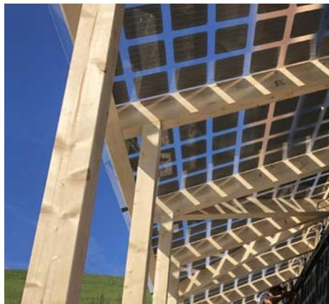
**stabile Holzkonstruktion in Kombination mit transparenten Doppelglasmodulen**
