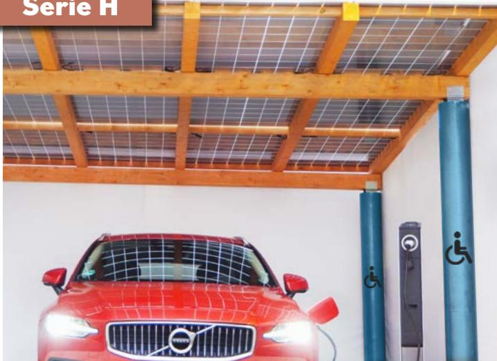
Konstruktionsvollholz auf Säulen aus Spezialstahl
